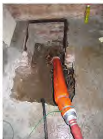
Aushärten des Liners
