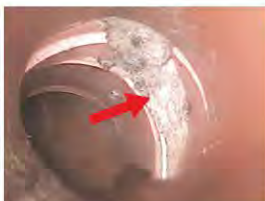
Verschobene Rohrverbindung
